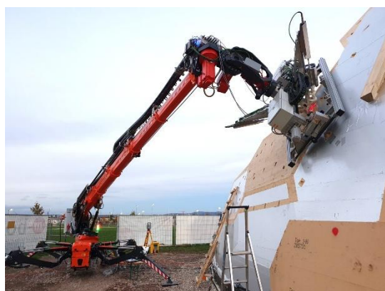
過去のドイツ短期滞在中で視察 (建設用クレーン型マニピュレータ)
