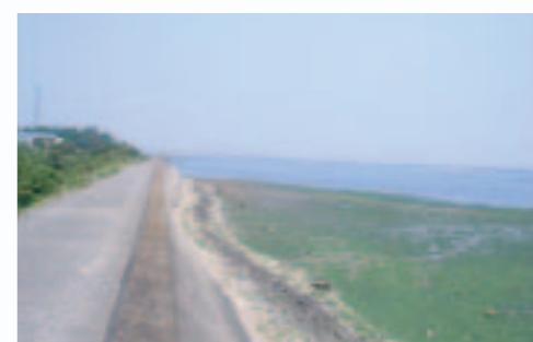
写真6 三河湾の防潮堤と残された干潟(渥美町)
