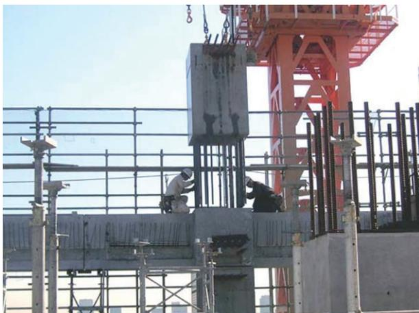
写真-1 柱PC建込み(1)
