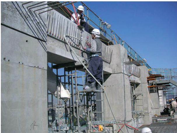
写真-3 梁PC建込み後のモルタル注入
