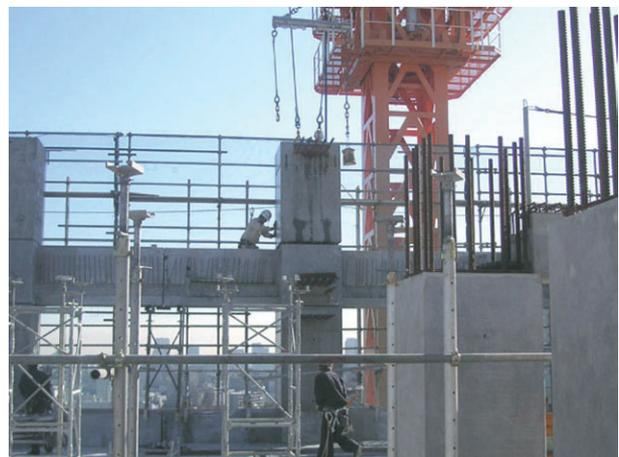
写真-2 柱PC建込み(2)
