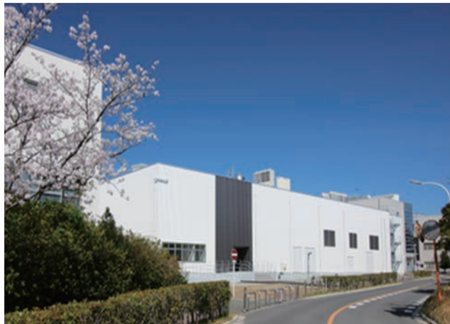
2025 年 3 月に新しく竣工した約 2,000m 2 の IRES 2 -4 (LSI 棟)
