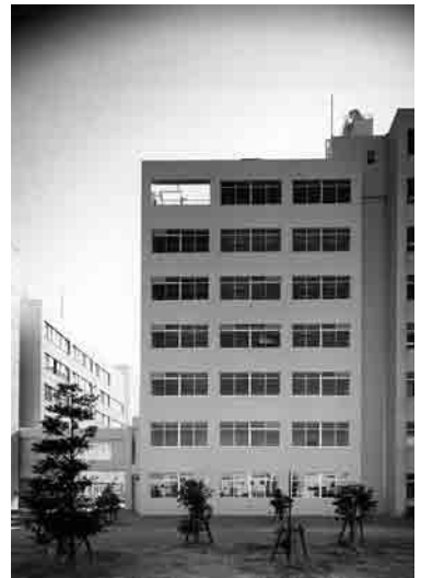
大学院棟建設（昭和62年）
