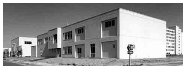
技術開発センター建設（昭和56年）
