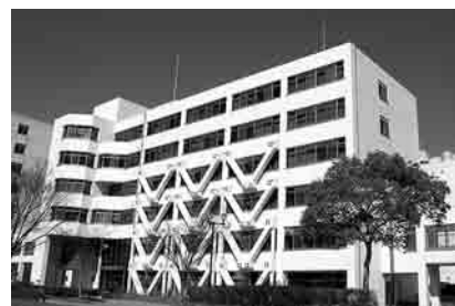
耐震補強工事により 外観が一変した C 棟
