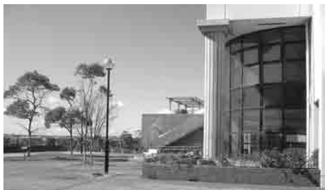
知識情報工学棟（正面ホール）
