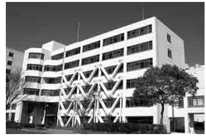
耐震補強工事により 外観が一新したC棟
