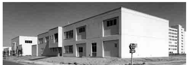
技術開発センター建設（昭和56年）
