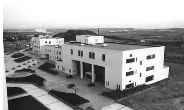
図書館建設（昭和55年）
