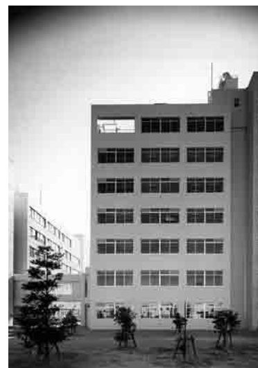
大学院棟建設（昭和62年）
