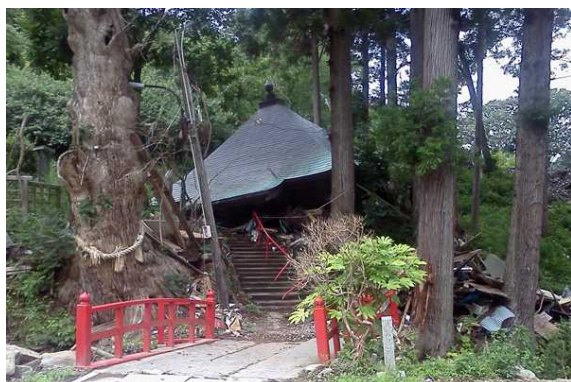
被災直後の天雄寺観音堂全景
