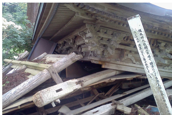
同観音堂の倒壊の様子
